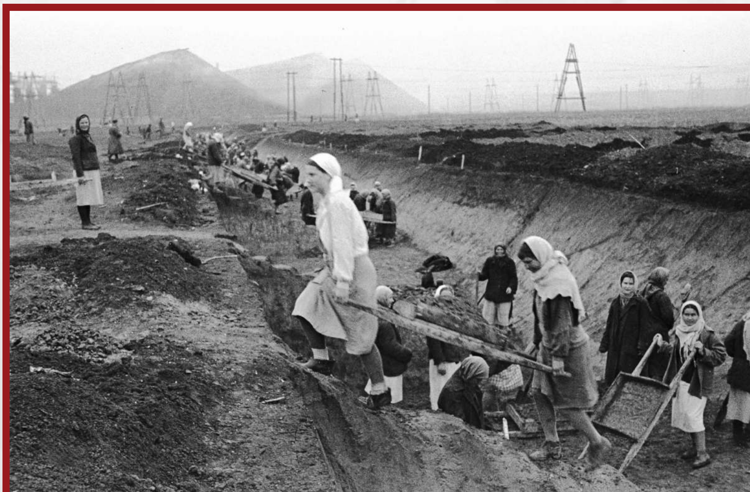
Строительство противотанковых рвов в районе Донбасса.
